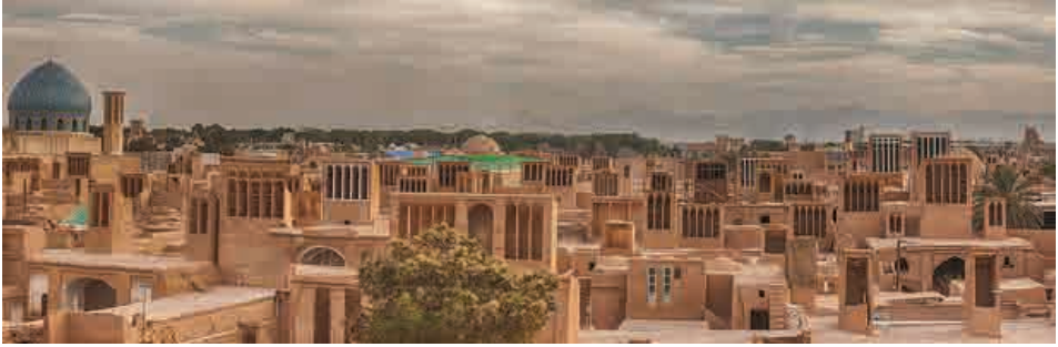
G. 1. Tek yönde açıklıkları bulunan rüzgâr yakalayıcıları, Ardekan, İran ( http://www.kheshtomah.com/about-us )
