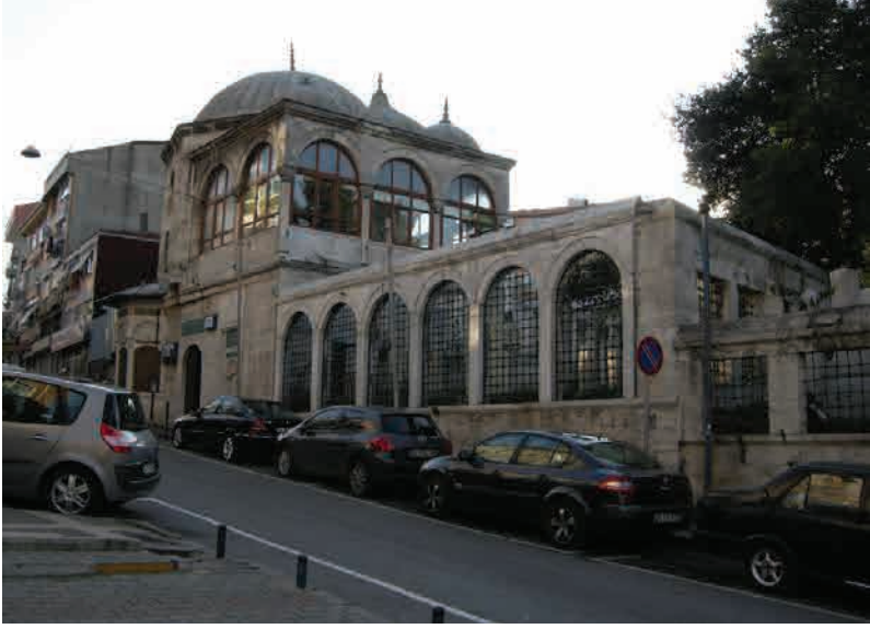
G. 12. Ahmediye Dershanesi Revakları'ndan Bir Görünüm (Seda COŞKUN, 2011)
