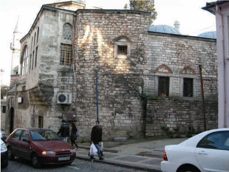
G. 20. Ahmediye Kütüphanesi'nin WC Cephesinden Bir Görünüm (Seda COŞKUN, 2011)
