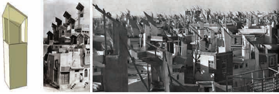
G. 2. Mangh ya da badkhor adlı rüzgâr yakalayıcılar, Haydarabad, Pakistan (Rodufsky, 1964, 114 ve 115 nolu resimler)
