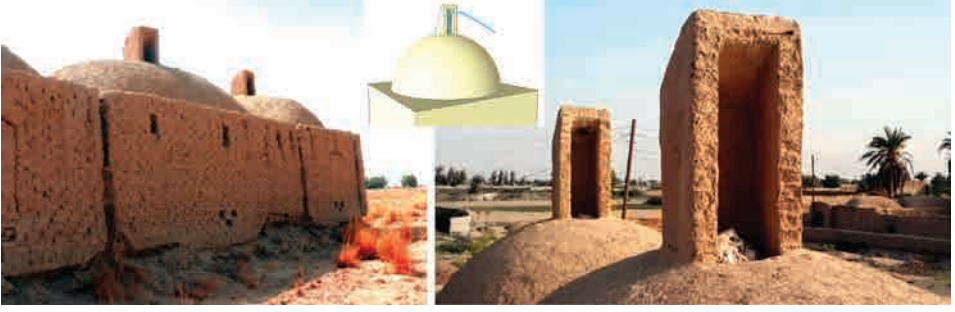
G. 5. Kubbe üstüne eklenen ve tek yönden rüzgâr alan rüzgâr yakalayıcıları, Sistan, İran (Sahebzadeh, Heidari, Kamelnia, Baghbani, 2017, s.22)
