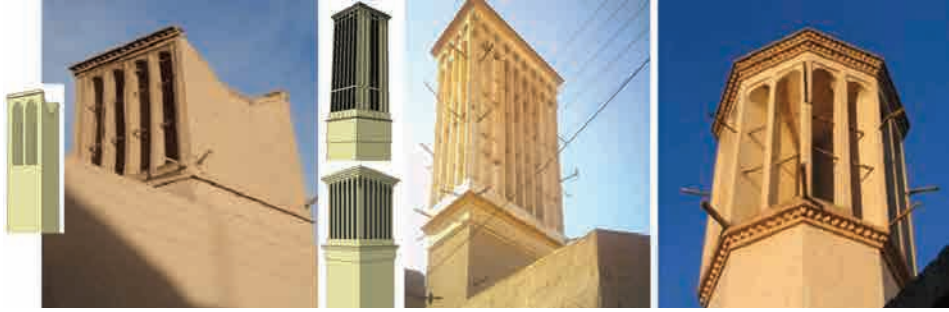
G. 7. Çok yönden (soldan sağa iki, dört ve sekiz) rüzgâr alan rüzgâr yakalayıcılar, İran (Montazeri, Azizian, 2008, s. 2194'den Ayhan Bekleyen tarafından uyarlandı.)
