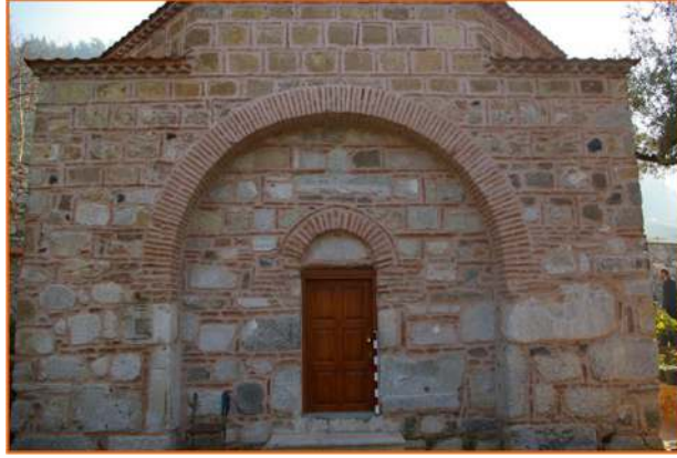
Figür 12. Revak Sultan Türbesi, giriş cephesi.
