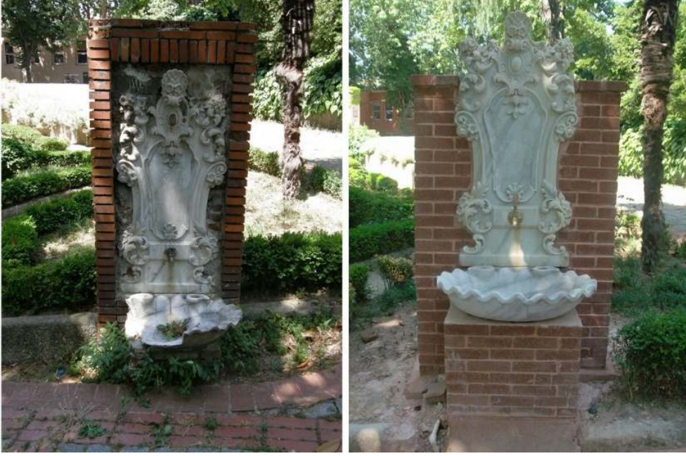
Figür 23. 9 numaralı çeşmenin koruma-onarım çalışmaları öncesi (solda) ve sonrasındaki (sağda) görünümü. Çeşmenin temizliği yapılmış, kırık kurnasının eksik kısmı yeni yontulan mermer ile tamamlanmış, tuğla ve hidrolik kireç bağlayıcılı harç ile hazırlanan yeni taşıyıcı duvara sabitlenmesi sağlanmıştır.
