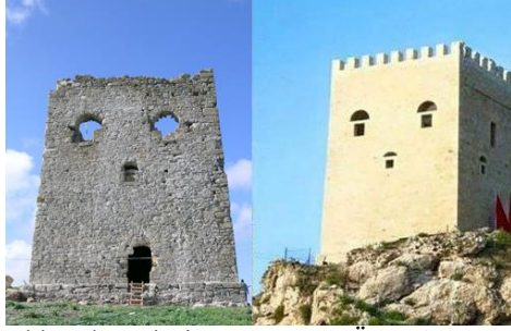
Şekil 3. Ocaklı Ada Kalesi Restorasyon Öncesi ve Sonrası
