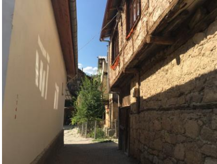
Şekil 18. Zemin kat taş ve üst katlar tuğla malzeme
