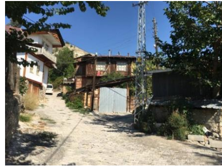
Şekil 17. Zemin kat taş ve üst katlar ahşap
