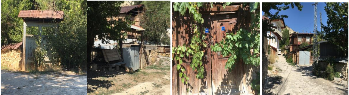
Şekil 14. Bahçe duvarı ve kapı örnekleri
