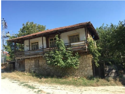
Şekil 16. Zemin kat taş ve üst kat kerpiç
