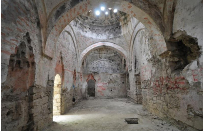
Resim 3: Ilıklık Mevânının Güneyden Görünüşü.
