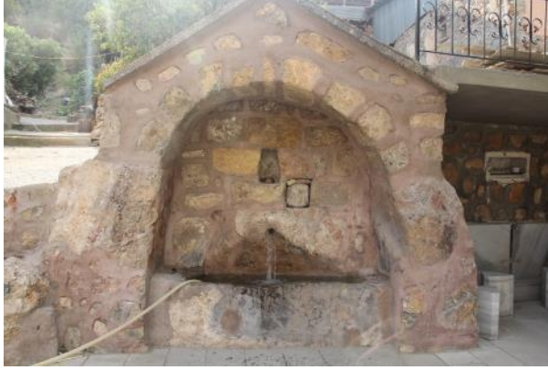
Foto.36. Armağan Köyü Cami Çeşmesi
