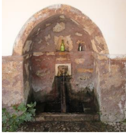
Foto.13: Hacı Şakir Ağa Medrese Çeşmesi
