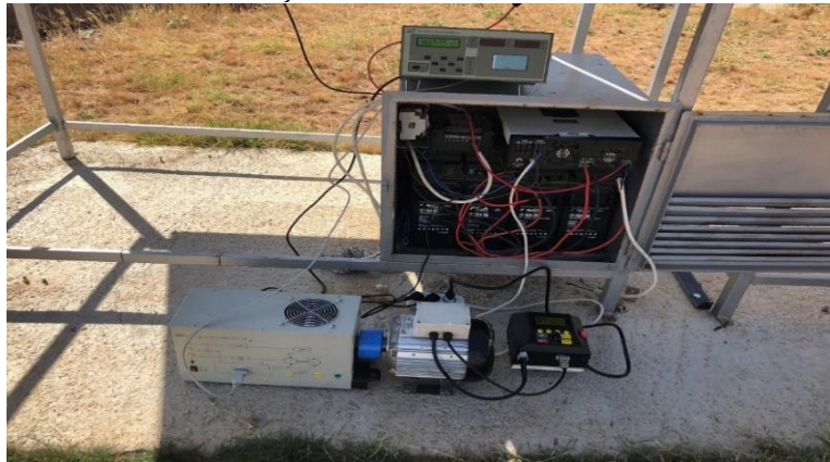
Şekil 7. Deneysel uygulama sistemi
