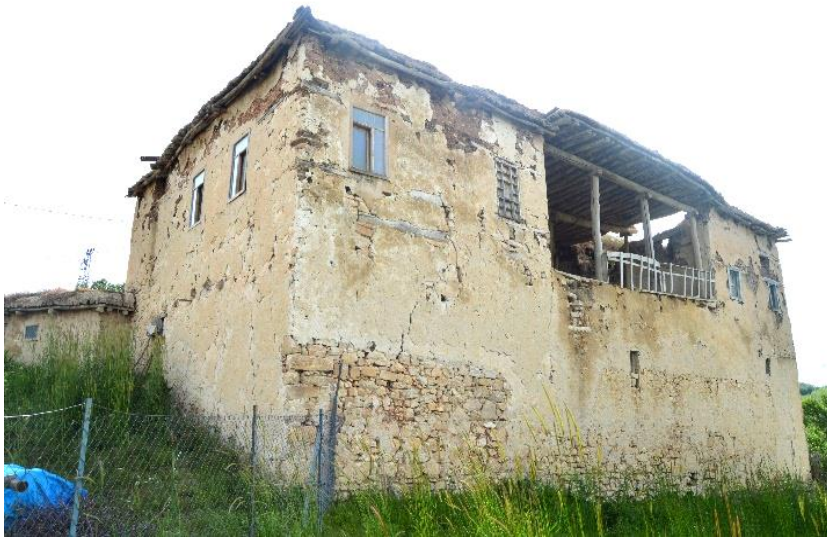
Foto-2: Evin ön cepheden genel görünüşü
