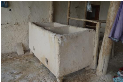
Foto-16: Ahşap çatki kerpiç dolgulu ambar genel görünüşü
