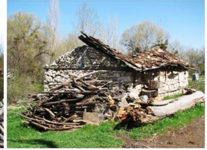
Yeğınler Köyü Aşağı Çamaşırhane
