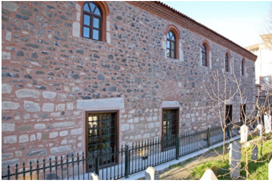
Resim 6. Onarımdan Sonra Dış Cephe Pencerelerinin Genel Görünümü.
