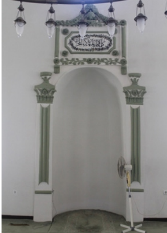
Resim 26. Mihrabın Onarımdan Sonraki Genel Görünümü
