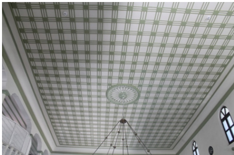
Resim 20. Onarımdan Sonra Harim Kısmının Tavanından Görünüm.
