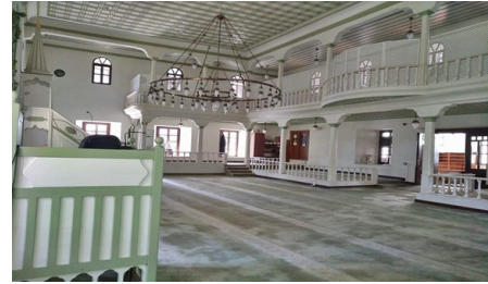
Resim 23. Onarımdan Sonra Harim Kısmının Tavanından - Görünüm
