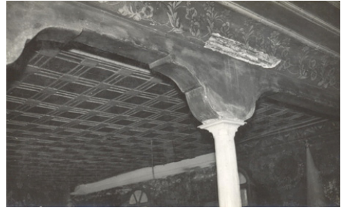
Resim 22. 1882 Yılına Ait Fotoğrafta Harim İçerisindeki Kalemşerlerinden Görünüm (VGMA'dan).
