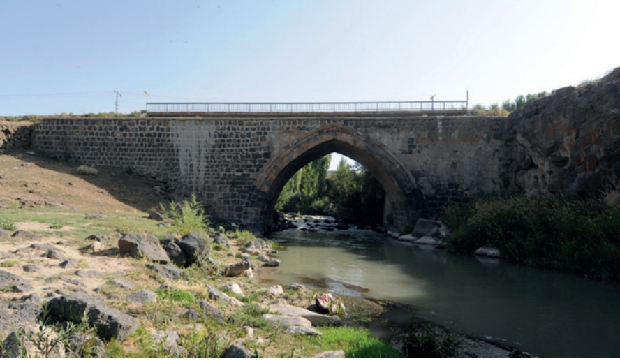
Foto. 6: Malazgirt (Hatun) Köprüsü mansap görünüşü
