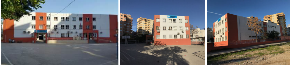
Şekil 4. Ramazanoğlu Ortaokulu (RO)
