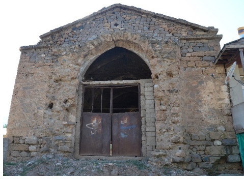
Görsel 5. Değirmenliköy kilisesi doğu cephesi genel görünümü
