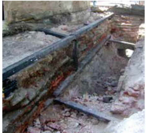
Fotograf 9. Sıvı kanalı içinde demir hatil sistemi
