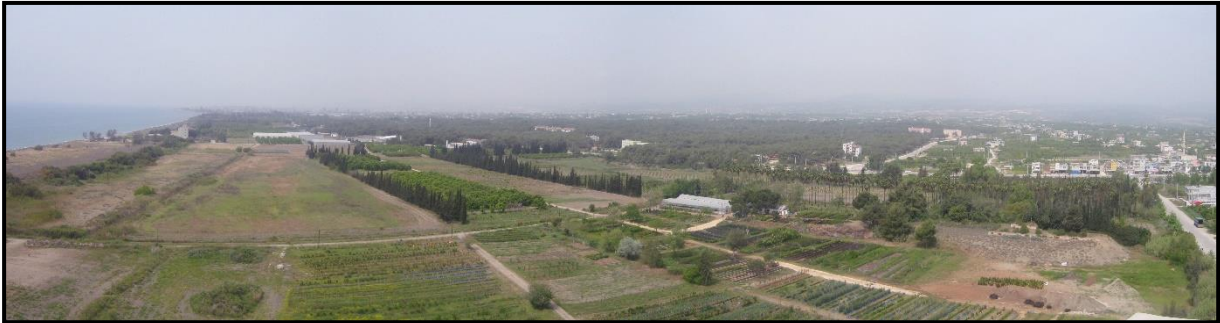
Şekil 8. Araştırma alanının Mersin-Erdemli arasındaki kıyı şeridinde yapılaşmadan korunabilmiş Alata Bahçe Kültürleri Araştırma Enstitüsü
