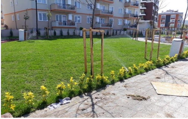
Şekil 24. Rotor Yağmurlama Başlıkları
