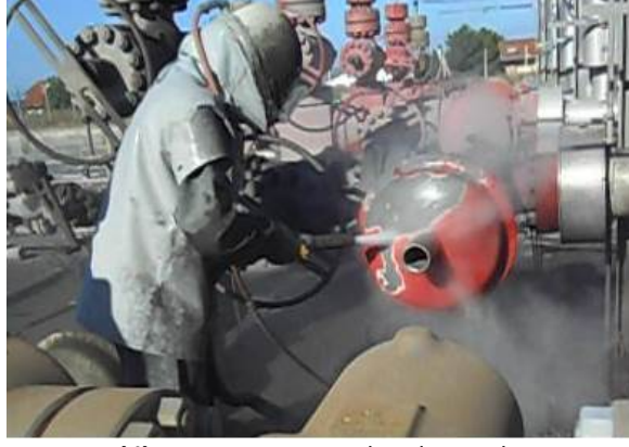
Şekil 1. Boyama öncesi kuşlama işlemi (Figure 1. Sand blasting operation before painting)
