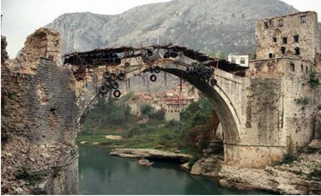
Şekil 2. Mostar Köprüsü'nün 27 yıl önce bombalandıktan sonraki görünümü (URL-1, 2019)
