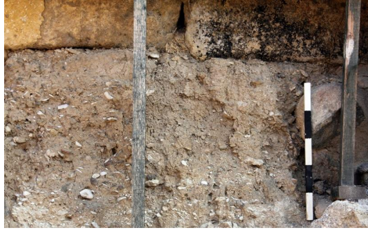
Fig.7: Kil taşı bloklar ve altında konumlanan dolgu toprağın kesit görünümü.
