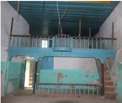
Fotoğraf 13: Kuzey duvar.
