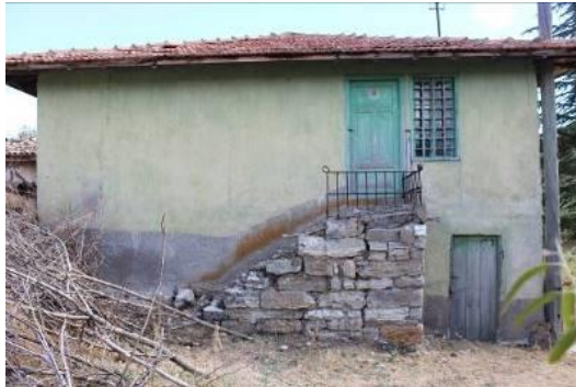
Fotoğraf 4: Kuzey cephe.
