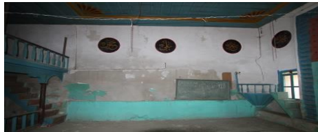
Fotoğraf 10: Doğu duvar.
