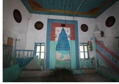
Fotoğraf 12: Güney duvar.
