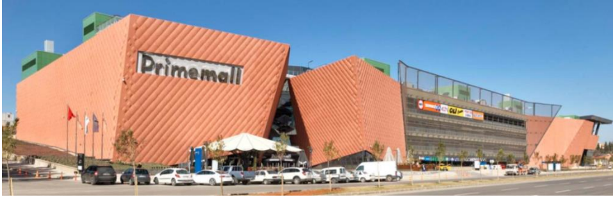
Şekil 15 Genleşmiş Metal Cephe Kaplaması Mevcut Cephe Görseli, (Özçelik, 2017)
