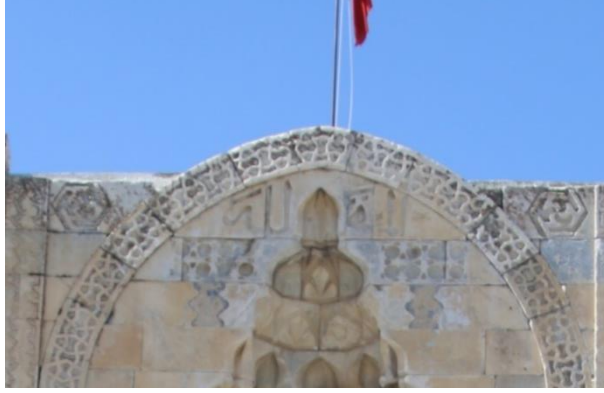
Görsel 3: Aksaray Sultan Hamı Taçkapısı Köşebentindeki Süsleme (A. Altın)
