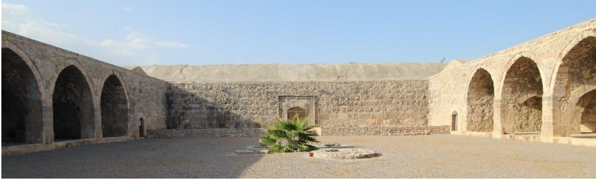
Fotoğraf 12: Kapalı bölüm ve revaklı avlu
