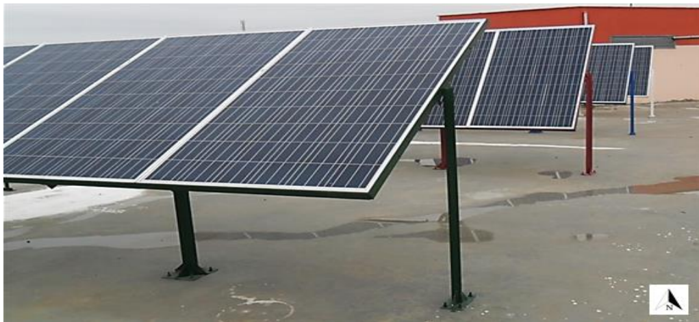
Şekil 3. Fotovoltaiklerin çatıda farklı eęim açlarındaki montajı
