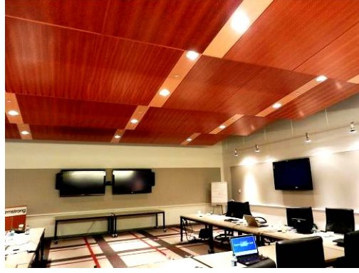
Şekil 12. Armstrong World Industries’de yer alan eğitim odası tavan yüzeyindeki ses yansıtıcılar (foto: M. KAVRAZ Arşivi)
