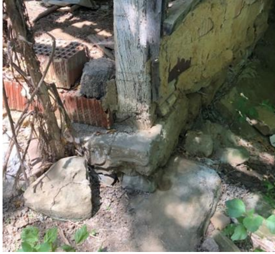
Şekil 8. Dikmenin zemindeki taşa oturtulması ve zemine yük aktaran daha büyük boyutlu taş
