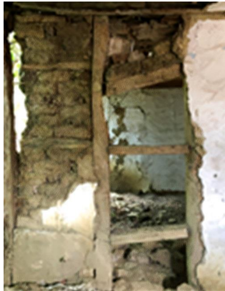
Şekil 4. Osman Ayvaz evi İç duvar tekniği
