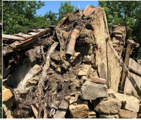
Şekil 3 b. Duvar örgüsünde toprak dolgu
