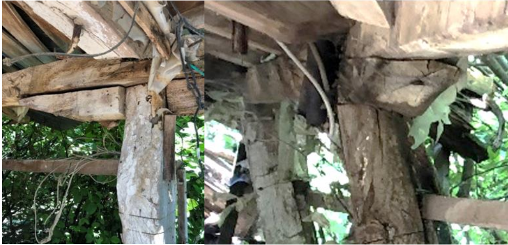
Şekil 7 a. Dikme aşık desteği
