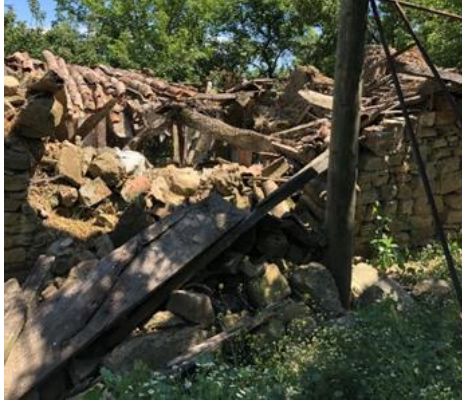
Şekil 3 a. Yapının arka duvarı
