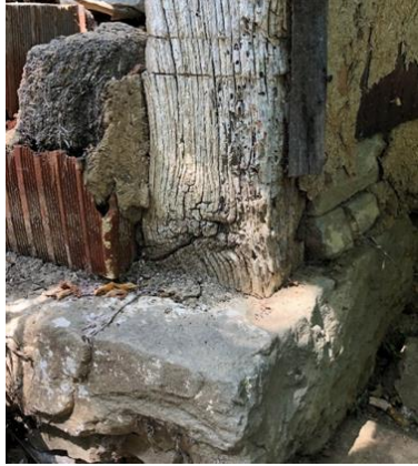
Şekil 9 a. Dikmenin taban birleşim detay fotoğrafı
