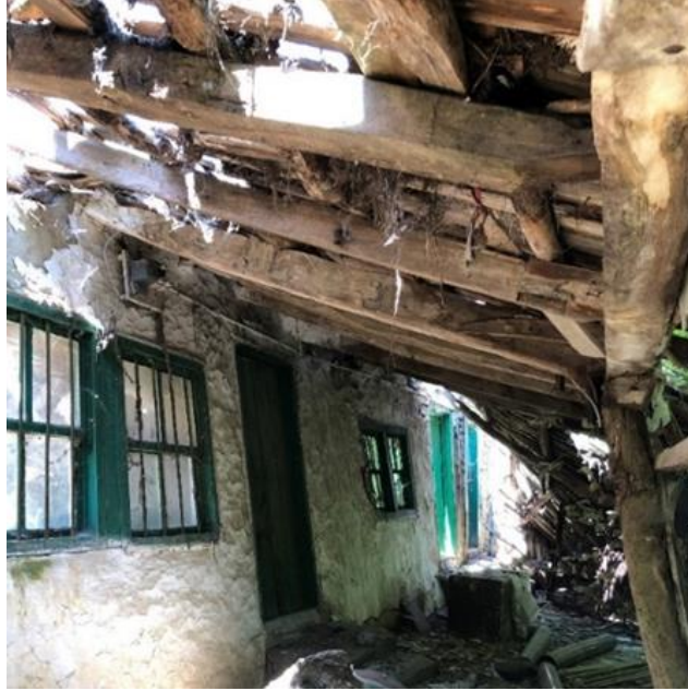
Şekil 5. Çatı örtüsünün açık sofa bölümü
