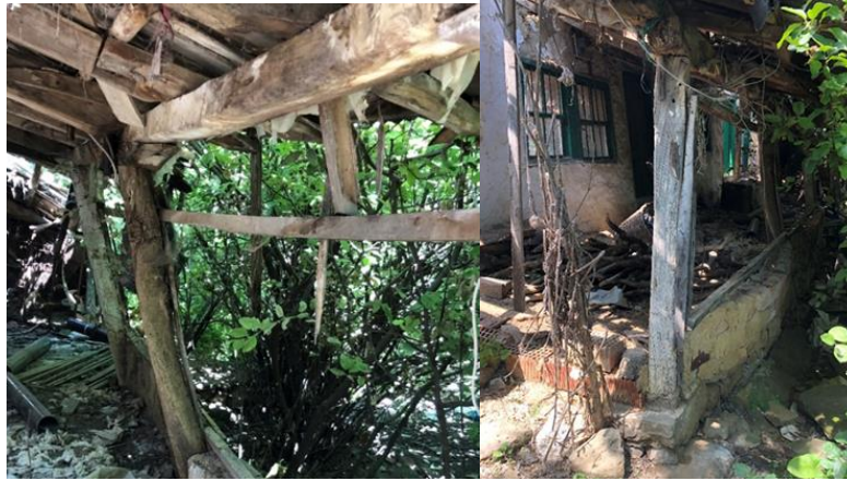
Şekil 6 a. Sofada kullanılan dikme ve aşıklar
