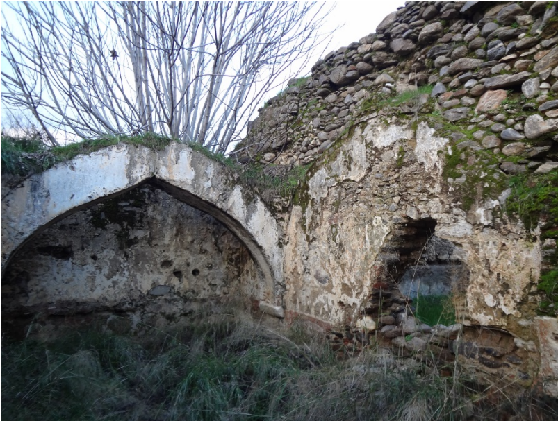
Res. 20- Suludere Köyü Hamamı, sıcaklik kuzeydoğu duvarı.
