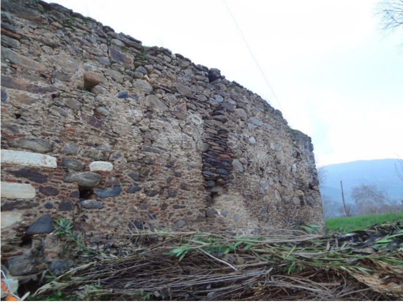
Res. 17- Suludere Köyü Hamamı, doğu cephe.
