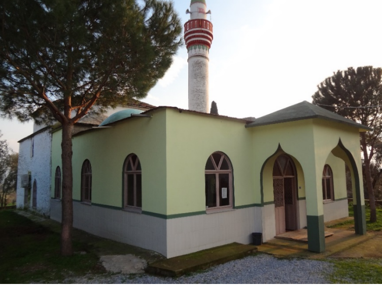
Resim 1- Suludere Köyü Camii, kuzey cephe.
