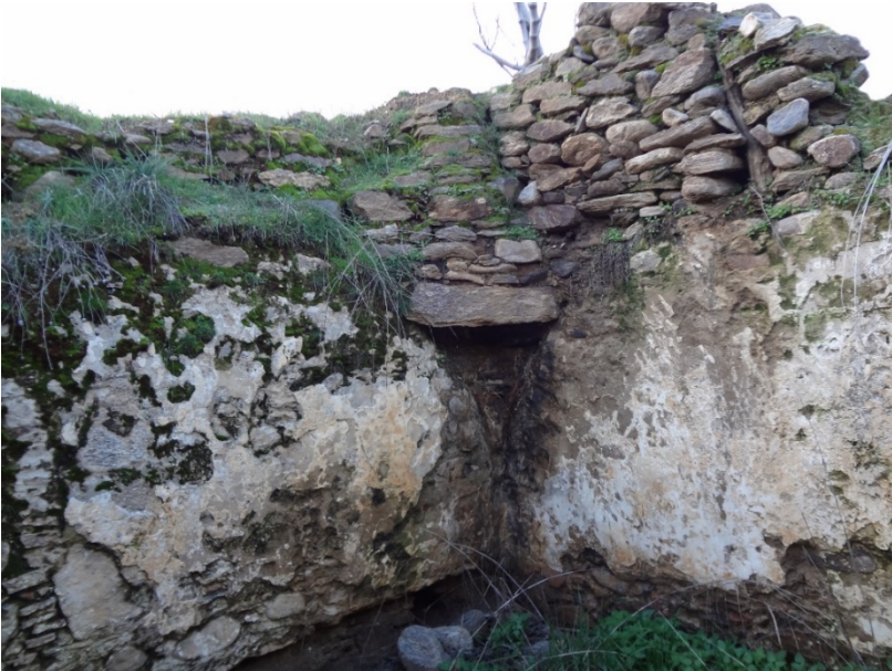
Res. 24- Suludere Köyü Hamamı, güney halvetin kuzeybatı köşesi.
