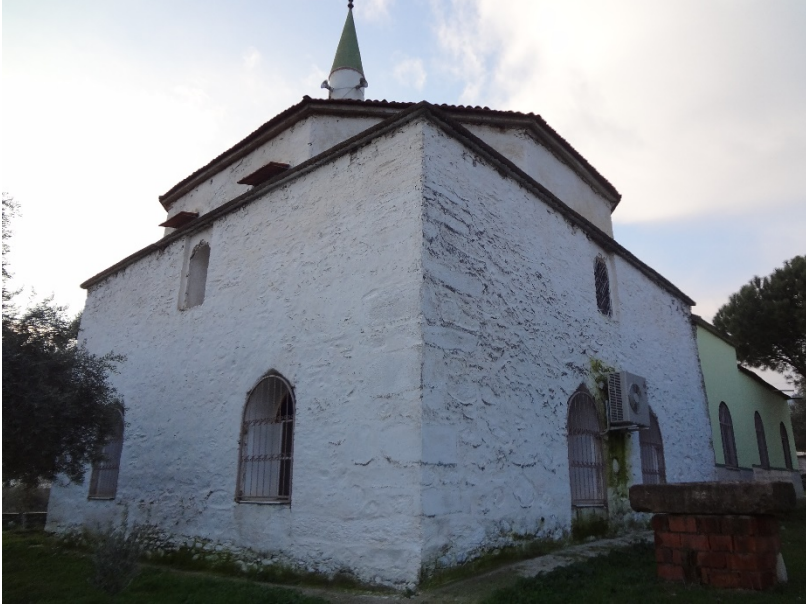
Resim 5- Suludere Köyü Camii, güneydoğu cephe
