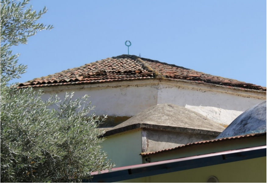
Resim 3- Suludere Köyü Camii, harim ve son cemaat yeri üst örtüsü.
