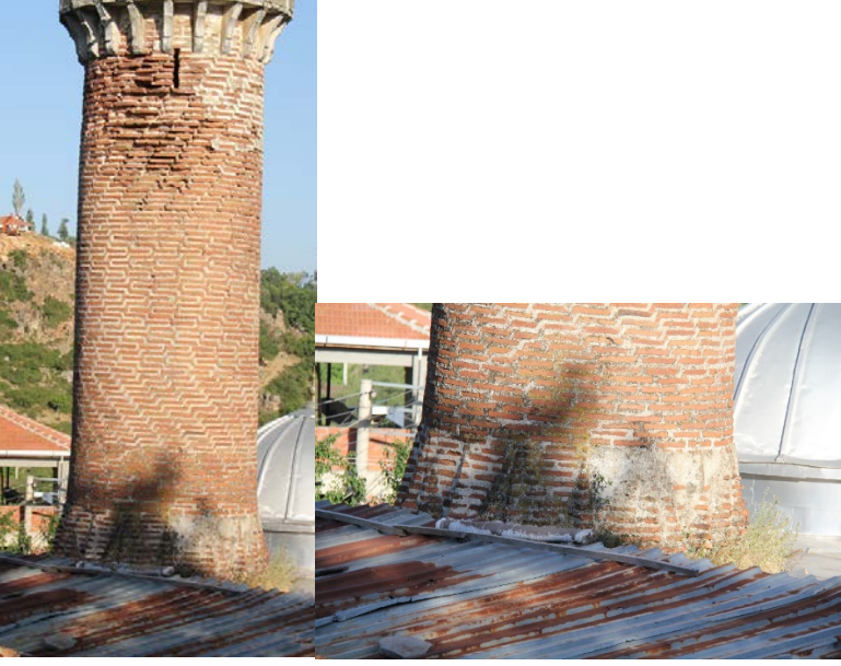
Resim 14, 15 - Kiraz, Cevizli Köyü Gözcü Baba Camii, minaresi ve pabuç bölümü.
