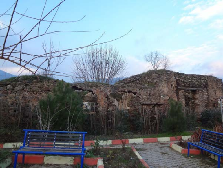
Resim 2- Suludere Köyü Hamamı, güney cephe.
