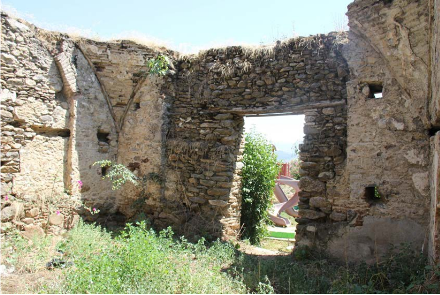
Res. 19- Suludere Köyü Hamamı, ılıklik mekânı güney ve doğu duvarları.
