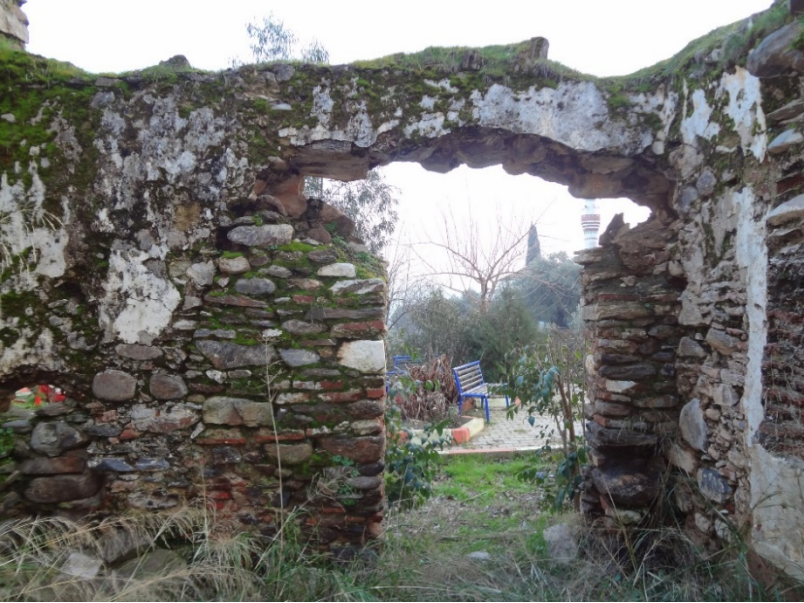
Res. 22- Suludere Köyü Hamamı, sıcaklık güney duvar.
