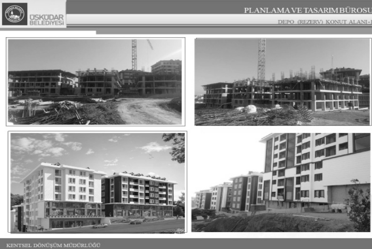
Şekil 5: Üsküdar Belediyesi Kentsel Dönüşüm Müdürlüğü Arşivinden Depo Konut Alanı -1 Şantiye Görüntüleri
