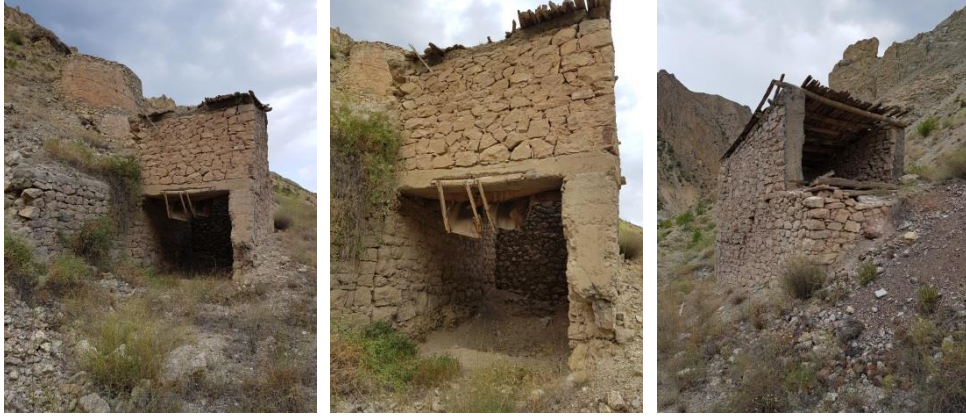
Fotoğraf 11. Aksu kireç ocakları- Yükleme rampası-Zemin kat nakliye araç alanı-Silo depo bölümü
