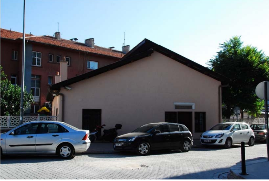
Fotoğraf 1: Ebû İshak-ı Kazerûnî Tekkesi Genel Görünüm
