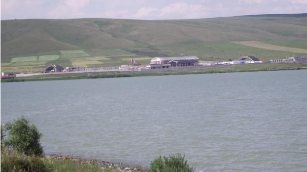
Resim-7. Aktaş Sınır kapısı hizmet binası (Kırpık, 2018).
