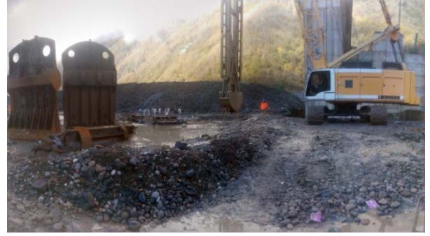
Şekil 6: Kirnati-Khelvechauri I Hes şantiyesi diyafram duvar uygulamasından bir görünüm
