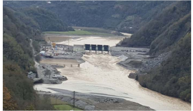
Şekil 2: Kirnati-Khelvachauri I Hes şantiyesi ön yüz fotoğrafı
