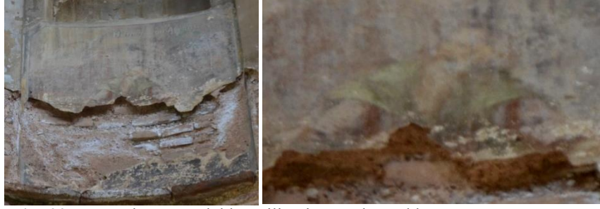
Resim 22. Kумыaka Başmelekler Kilisesi, Narteks Kubbe Kasmağı, Kuzey Duvar, İbrahim'in İshak'ı Kurban Etmesi
