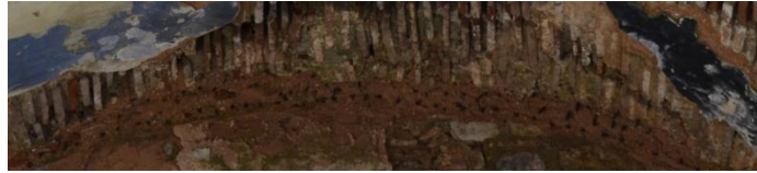
Resim 34. Kumyaka Başmelekler Kilisesi, Kuzey Duvar, Sıva, Agregada
