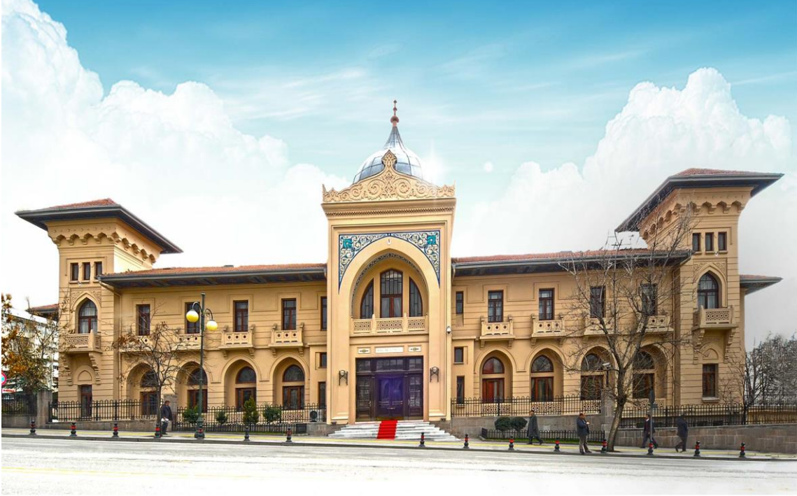
(Foto:9 ) Giriş kapısı teras kat
