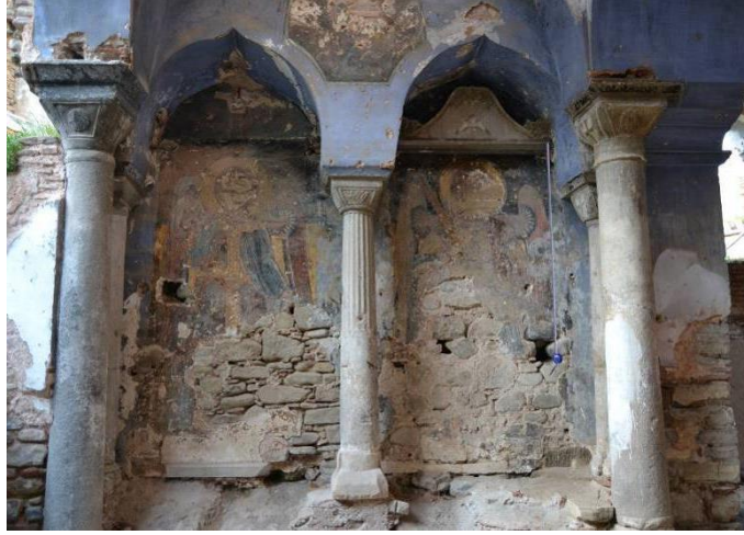
Resim 26. Kумыака Başmelekler Kilisesi, Narteks Kuzey Duvar, Başmelekler
