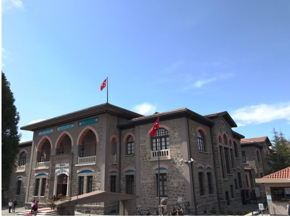
Foto:1 Giriş ve Yan Cephe görünüşü (2. TBMM. Binası. )
