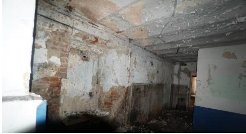
Resim 1: Bodrum katın kağır duvarları
