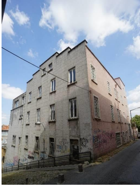
Resim 7: Yapının güneydoğu cephesi ile kuzeybatı cephesi
