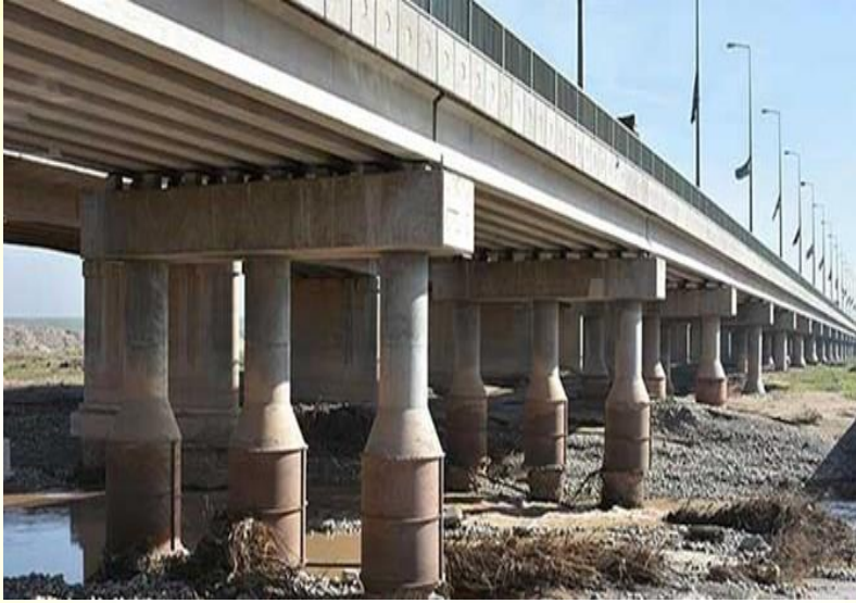
Ek 2: Dakuk Taş Köprüsü ( https://www.aa.com.tr/tr/dunya/irakin-en-uzun-koprusunde-cokme-riski-var/1340496 )
