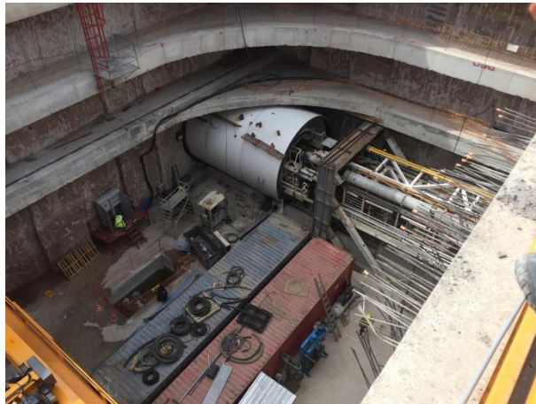
Şekil-6. Top- down kazısı tamamlandıktan sonra TBM yapılarının oluşturulmaya başlanması
