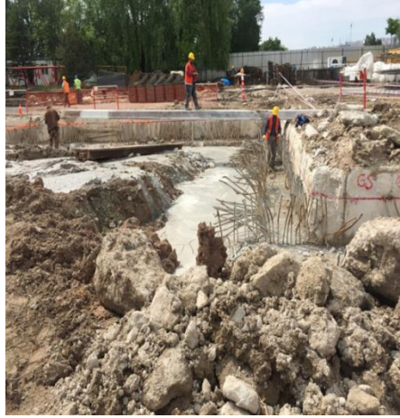
Şekil-3. İmalatı tamamlanan diyafram perdeler
