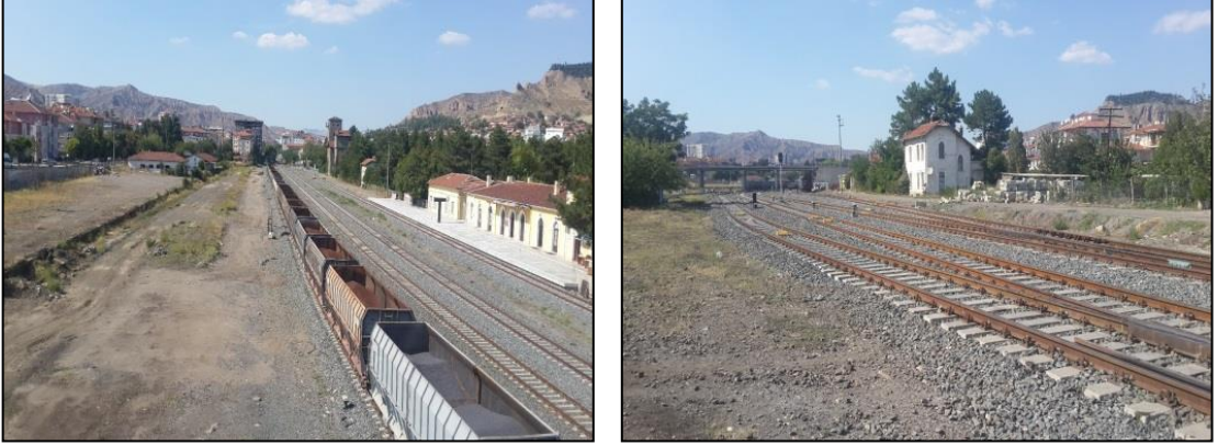
Şekil 2. Tren rayları ve gar binası (Çankırı Belediyesi, 2019b)
