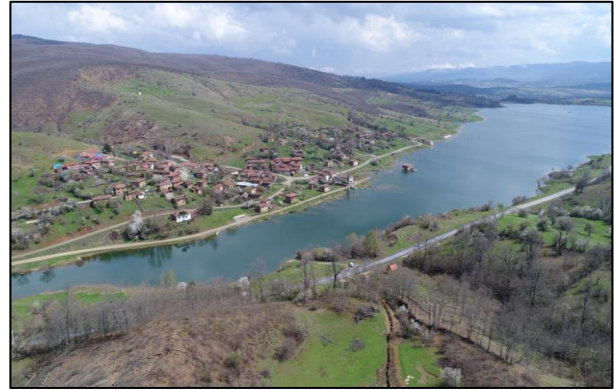
Şekil 3. Günyurdu Barajı, drone ile fotoğraf çekimi (Orijinal 2019)
