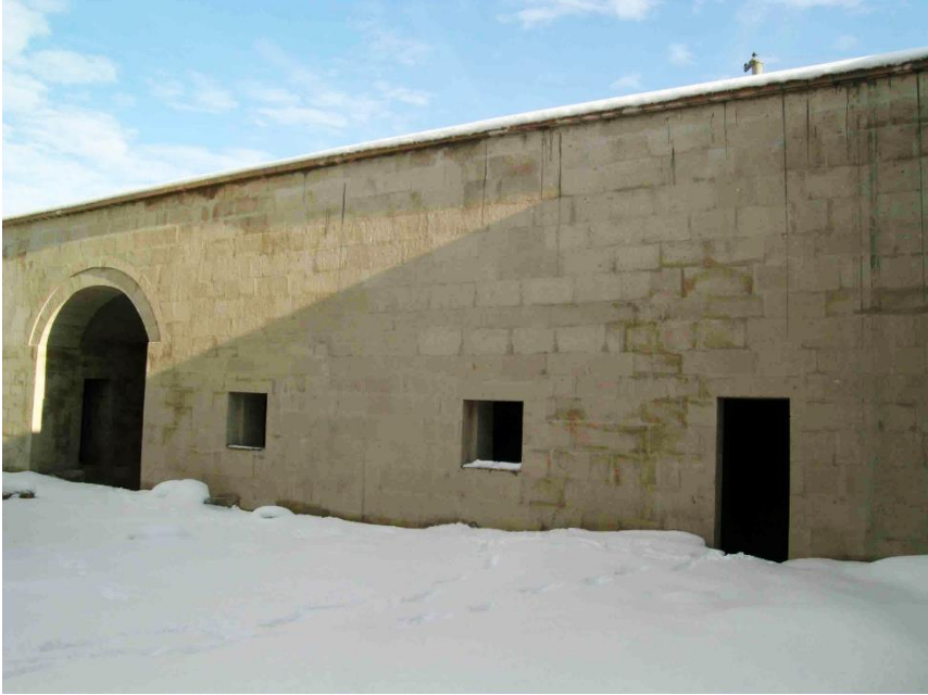
Foto 10: Avlu Güney Kanat (Onarım Sonrası)
