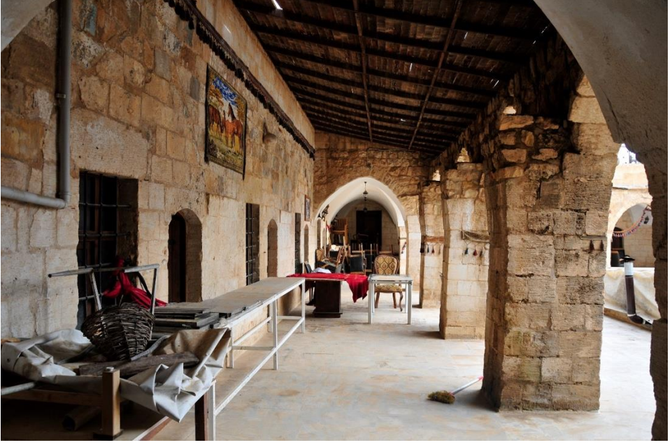
Fotoğraf 24. Hacı Sadık Ağa Hanı Doğu Kanat Revakı
