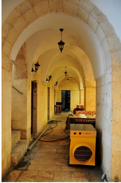
Fotoğraf 14. Hacı Sadık Ağa Hanı Zemin Kat Güneybatı Revakları
