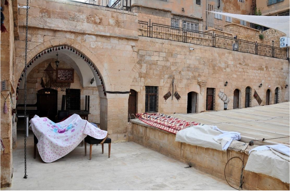
Fotoğraf 22. Hacı Sadık Ağa Hamı I. Kat Batı Kanadı ve Revak Kalıntısı
