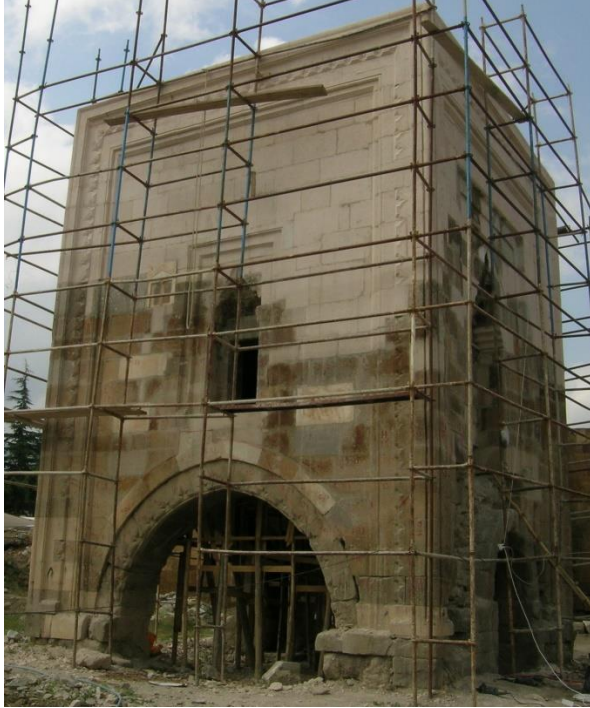
Foto 12: Köşk Mescit (Onarım Sonrası)
