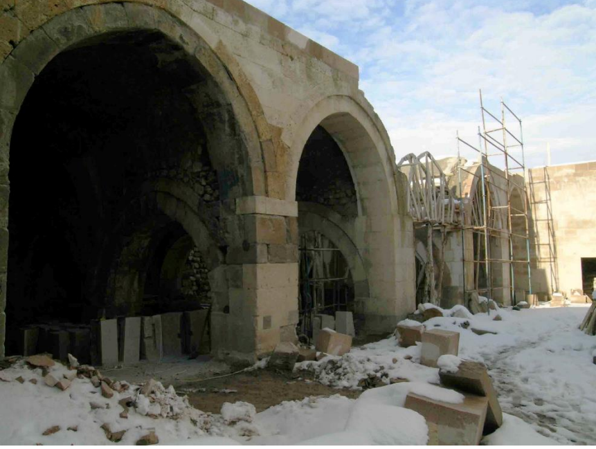
Foto 9: Avlu Kuzey Kanat (Onarım)
