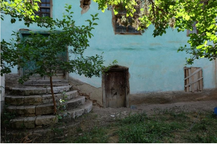
Foto.4. Belekler Köyü Cami Batı Cephe – Avlu ve Giriş
