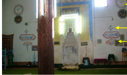
Şekil 21: Güney Duvarı Sıva Üstü Kalem İşleri (2012 restorasyonu öncesi) (Kaynak: K.V.B.M. Arşivi)
