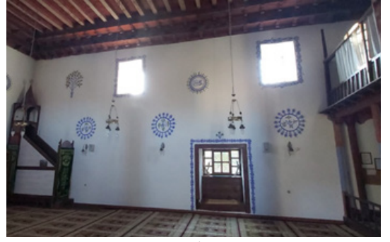
Şekil 31: Batı Duvarı Kalem İşleri (2012 Restorasyonu Sonrası)
