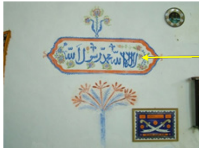
Şekil 23: Güney Duvarı Sıva Üstü Kalem İşleri (2012 restorasyonu Öncesi), (Kaynak: K.V.B.M. Arşivi)
