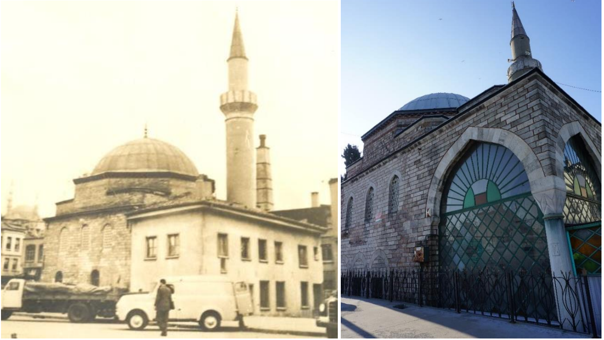
Şekil 12. (Solda) Yavuz Er-Sinan Camii (Anonim, tb1) Şekil 13. (Sağda) Yavuz Er-Sinan Camii (Anonim, tb2)
