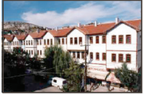
Fotoğraf 10: Bindirme tekniđi ile betonarme yapıların kamuşlaji
