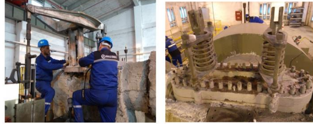
Şekil 11. Kontrol vanası bakım çalışmaları.
