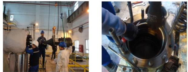
Şekil 9. Trip vanalarının demontajı ve sızdırmazlık elemanlarının değişimi.
