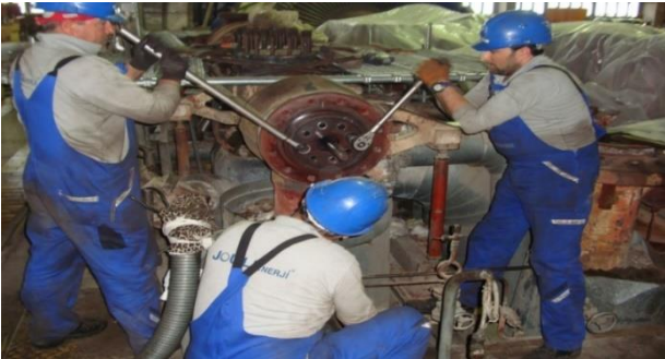
Şekil 6. Trip vanası demontajı.
