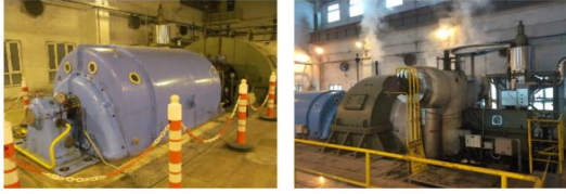
Şekil 10. Buhar türbini devreye alma çalışmaları.
