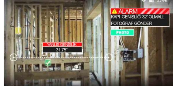
Şekil 6.Şantiyede AR Uygulaması (SRI International, 2017)
