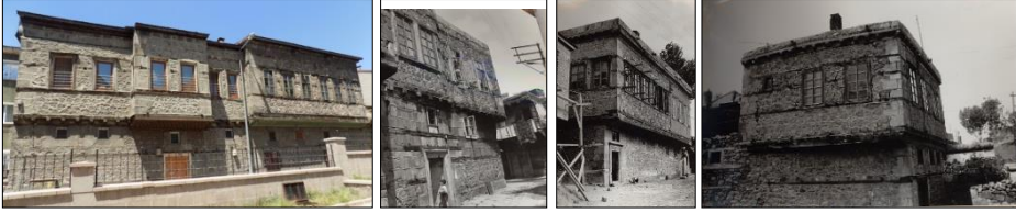
Foto 5. Çoklu çıkmalı cephe örneği: Dursun Akal Evi (1754), kademeli ve gönye çıkmalı cephe örneği: Alipaşa Cami Sokak Evi (19. yy. son çeyreği), kat çıkma örneği: Hanağasıgilin Ev (1868), Avni Beyin Evi (19.yy. ortaları).
