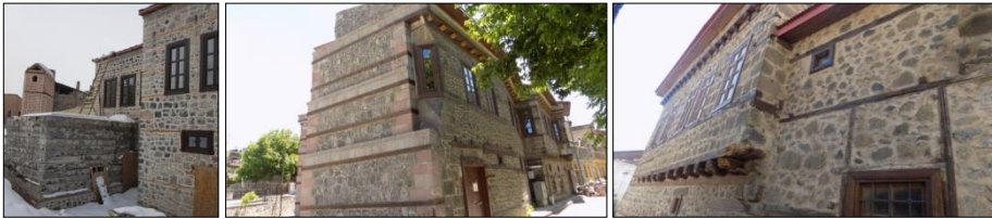
Foto 2. Erzurum Evi arka cephe örneği: Fehimoğlu Evi (19. yy. sonları), gönyeli ve açılmalı kırılmalı cephe örneği: Habib Baba Konağı (19. yy. üçüncü çeyreği), gönye çıkmalı cephe örneği: Hacı Kazım Efendi Evi (19. yy. ortaları).
