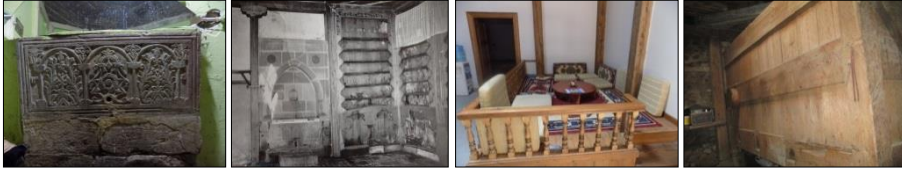
Foto 10. Zemin kat yapı elemanları-tandirevi; kurun örneği: Fikri Evin Evi (1887), kurunlu çeşme ve terek örneği: Abdulhamit Bey Konağı (1887), seki örneği: Boy Beyi Yusuf Beyin Evi (1904), ambar örneği: Kadıhaftızoğulları Konağı (1786).
