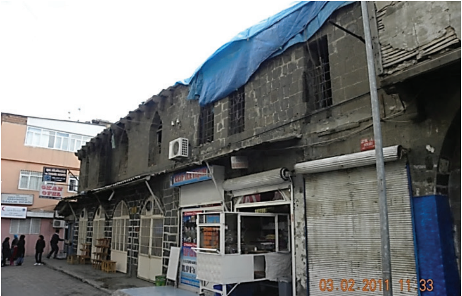
Foto. 14: Çifte Han Kuzey Cephe Görünüşü.
