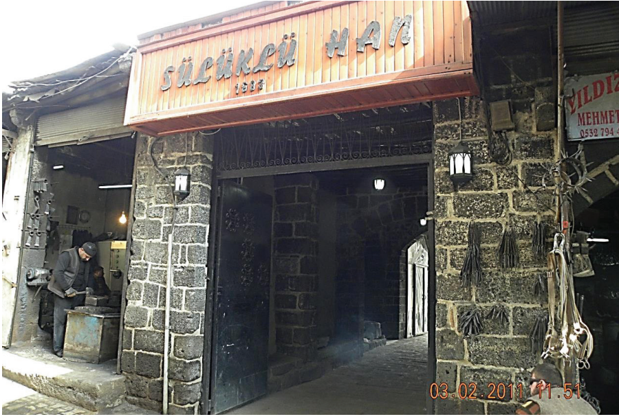
Foto. 20: Sütlüklü Han Bau Cephe Girişi.
