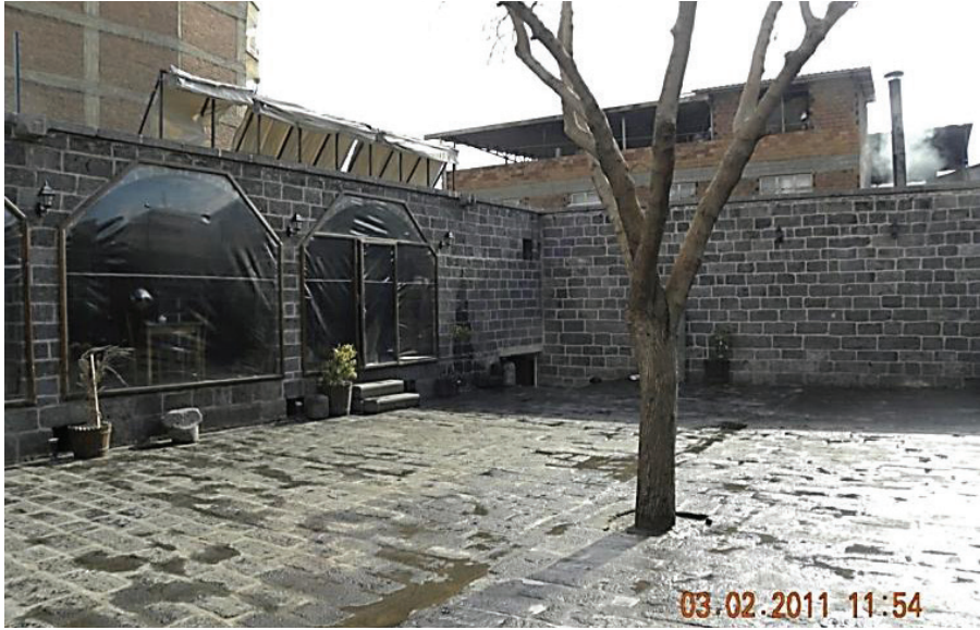
Foto. 21: Sütlüklü Han Revaksız Avlu Güney Kanadı ve Revaklı Doğu Kanadı.
