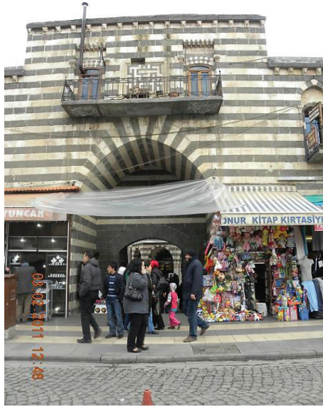
Foto. 9: Hasan Paşa Hamamı Bau Girişi.
