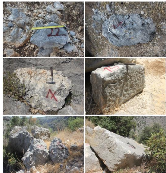
Şekil 4. Çalışma alanında gözlenen düşmüş bloklardan örnekler
