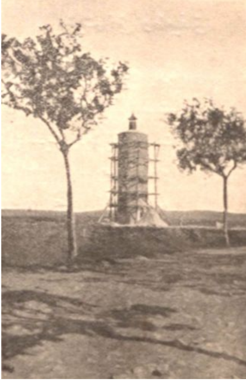
Resim 1. Hamidiye Su Terazisi inşaatından (26 Haziran 1902 Servet-i Fünun no.583)
