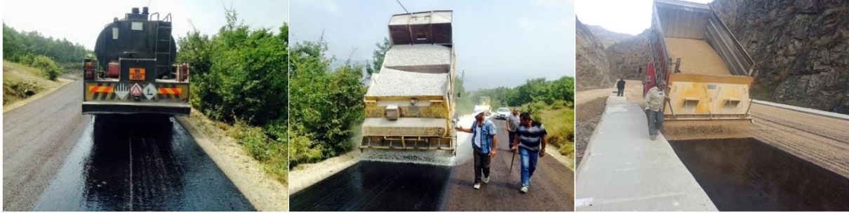
Şekil 1. Sathi kaplama çalışmaları.
