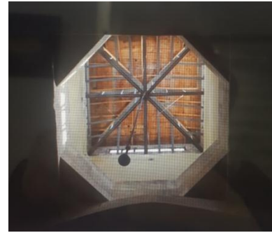
Resim 6: Camlı Demir Doğrama Külâh.
