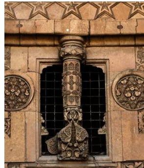
Resim 8-9: Denge Sütunları, (Sağ Taraftaki Sütun, Mıknatısla Dönmekte İken Deprem Sonrası Bozulmuştur.)
