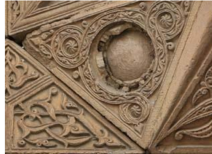
Resim 27: Batı Kapı, Kırık Taş İşlemeleri.
