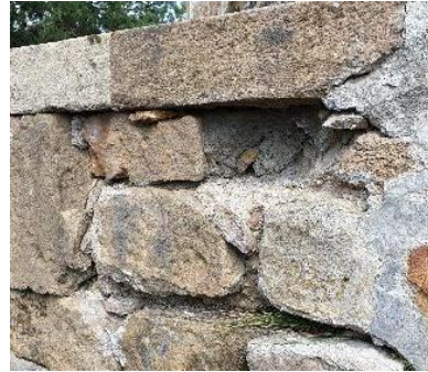
Resim.8: Malzeme-parça kaybı, aşınma-ufalanma
