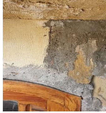
Resim.3- 4: Yenilenen taş-tuğla ve beton harç kullanımı
