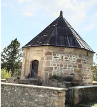
Resim.3- 4: Yenilenen taş-tuğla ve beton harç kullanımı
