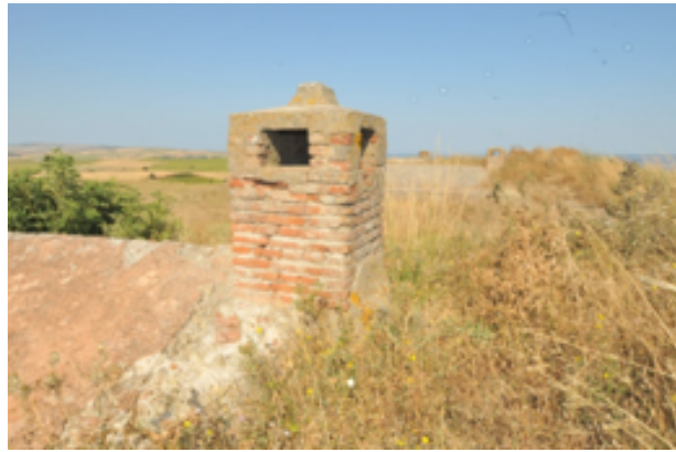
Resim 15. Tabyanın Üst örtüsü ve Ayakta Kalan Bacalarından Bir örnek
