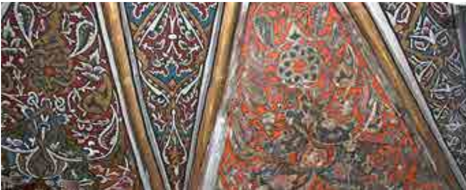
Fotoğraf 5. Yıldız tonoz içinde raspa yapılan bölge
