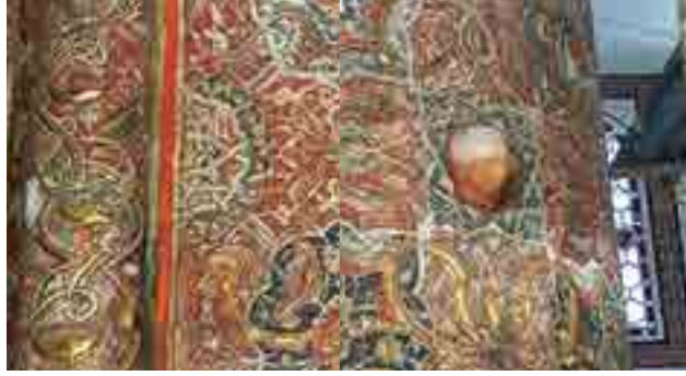
Fotoğraf 21. Kuzey cephesi filpayelerin onarım öncesi ve sonrası
