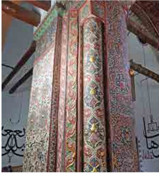
Fotoğraf 22. Kuzey cephesi filpayesinin yan yüzeyi
