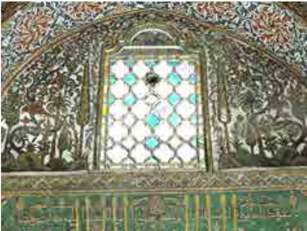
Fotoğraf 16. Güney cephesi hayat ağacı (Onarım öncesi)
