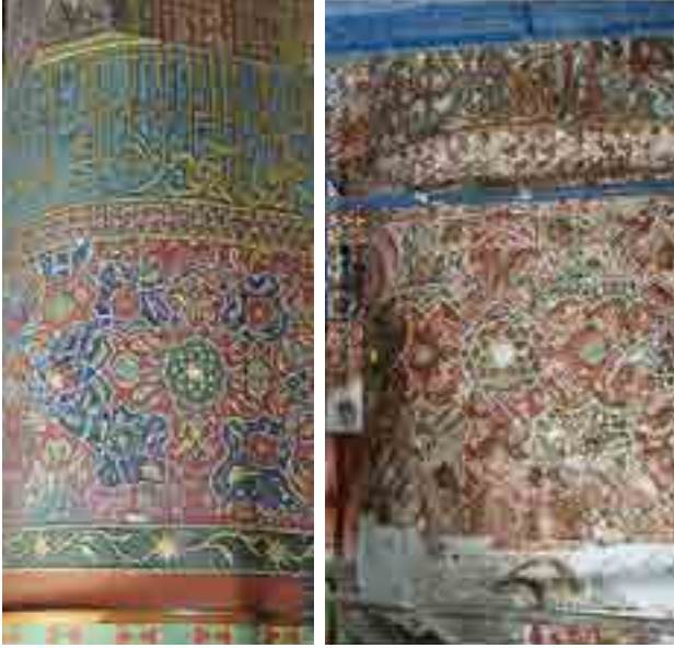
Fotoğraf 19. Güney cephesi filpayelerin onarım önsesi ve temizlenmiş hali
