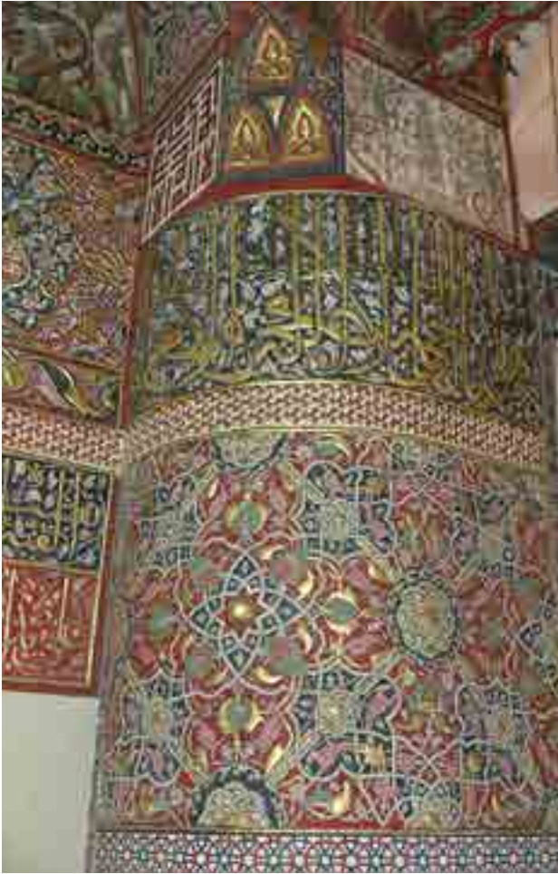
Fotoğraf 20. Güney cephesi filpayenin onarım sonrası
