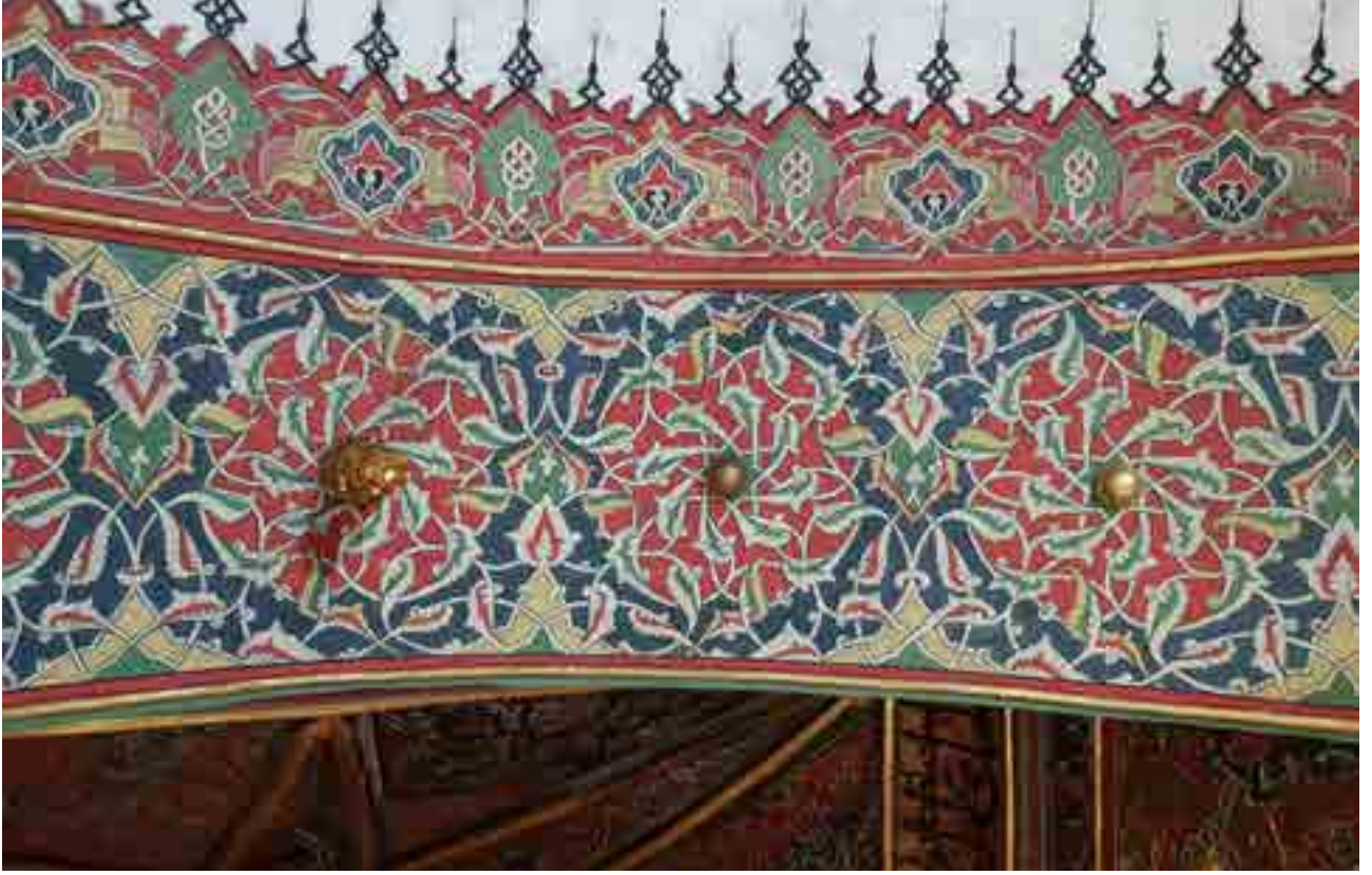
Fotoğraf 13. Kuzey ve güney cepheleri kemer içi (Onarım sonrası)
