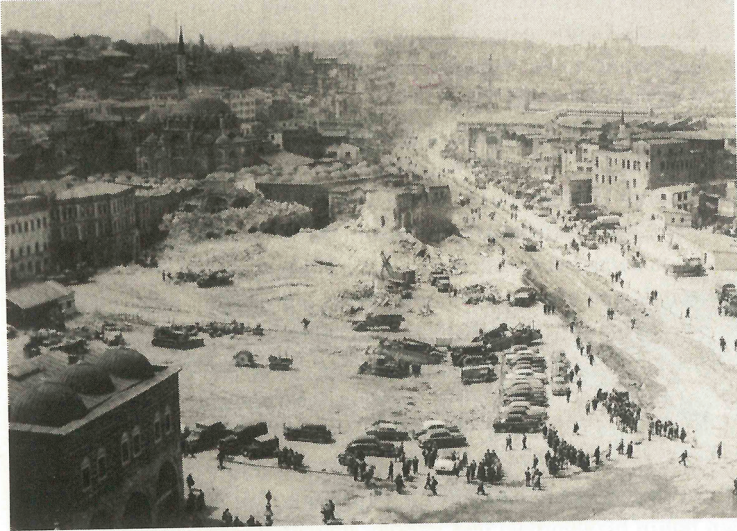
Fotoğraf 9. Eminönü Meydanı Düzenlemeleri Kapsamında Yürütülen Yıkım ve İnşa Faaliyetleri
