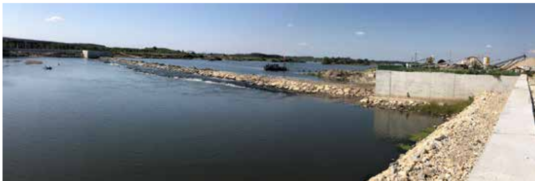
Foto 3: Kaya dolgu set, arkasında durgun bir su ortamı yaratarak kum birikmesine yol açan önemli bir rol oynamaktadır.
