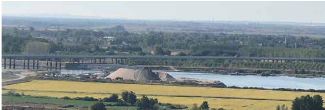
Foto 1: Dr. Mehmet Müezzinoğlu köprüsü ve Meriç nehri kum madenciliği deposu. Photo 1: Dr. Mehmet Müezzinoğlu Bridge and sand mining warehouse on the banks of the River Meriç.
